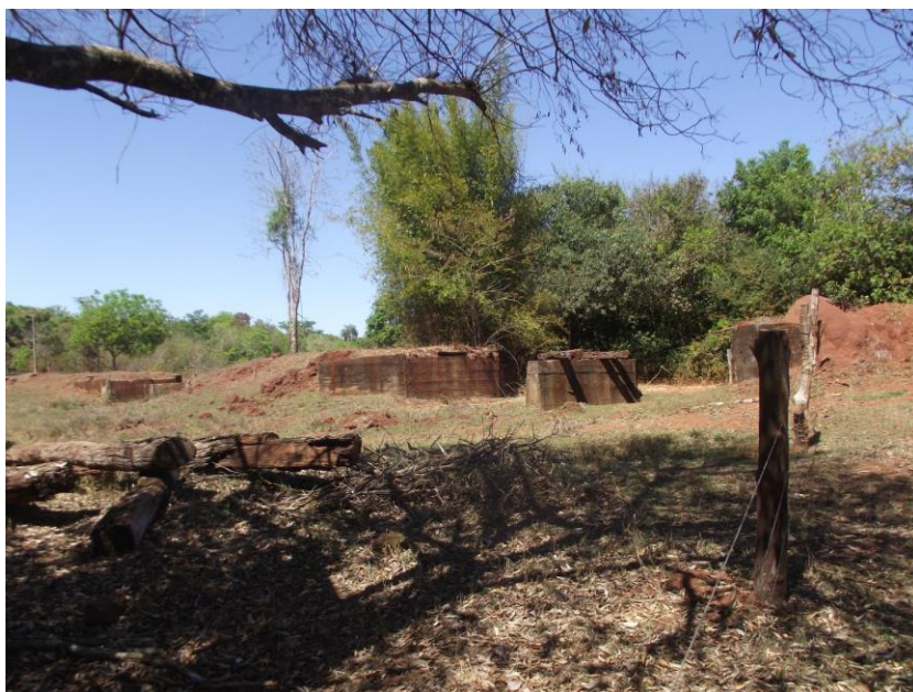
Figura 5: Ruínas da antiga ponte sobre o rio São Gabriel.
