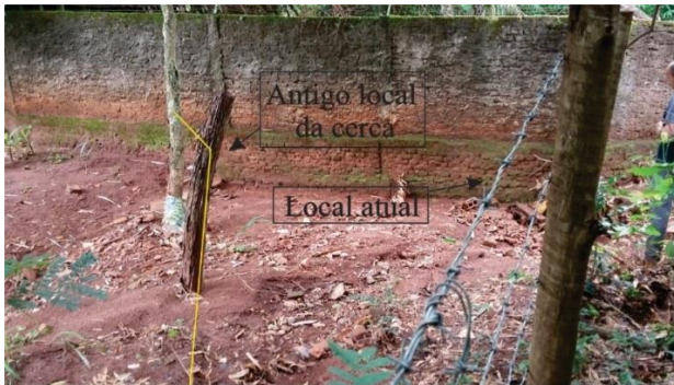
Figura 1: Avanço de uma propriedade vizinha sobre a área do parque
