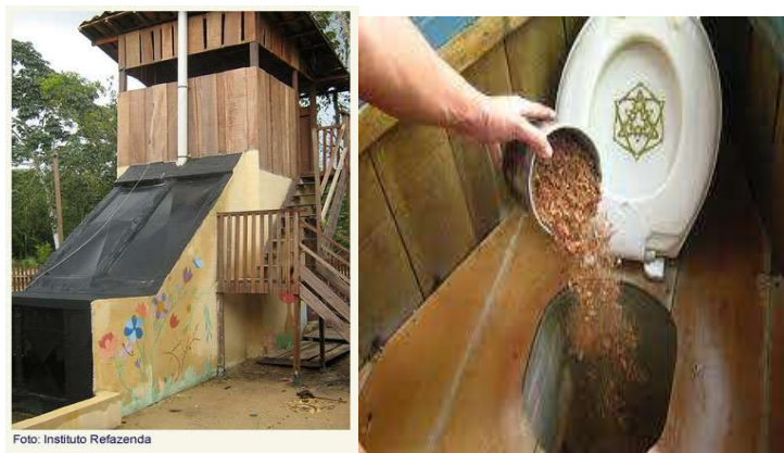
Figura 7 - Banheiro seco. (A) exemplo de estrutura; (B) adição de serragem;
