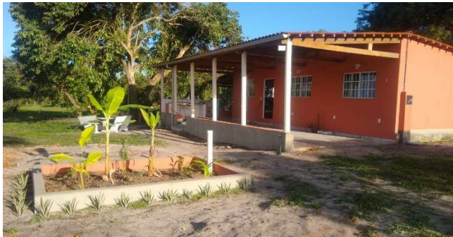
C – detalhe da fossa final, com o plantio de bananeiras e outras plantas
