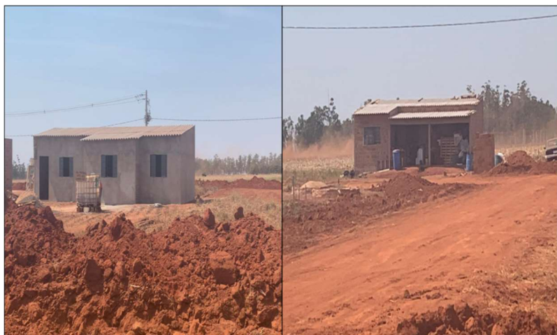
Figura 7: Modelo de construções no bairro Esplanada V
