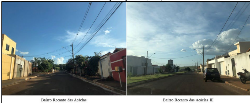
Figura 4: Calçamento nos bairros Recanto das Acácias I e III em Capinópolis (MG)
