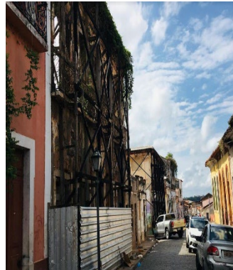
Figura 6 – Casario em ruína
