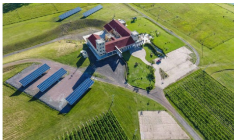
Figura 2: Vinícola Guatambu – Painéis solares e videiras
